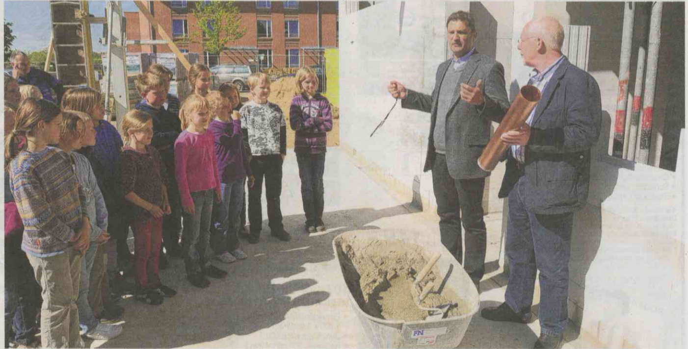
Thomas Butzlaff (2. v. r.) und Jens Bieber (r.) bereiten die Grundsteinlegung der neuen Grundschule Op de Host in Horst vor.
