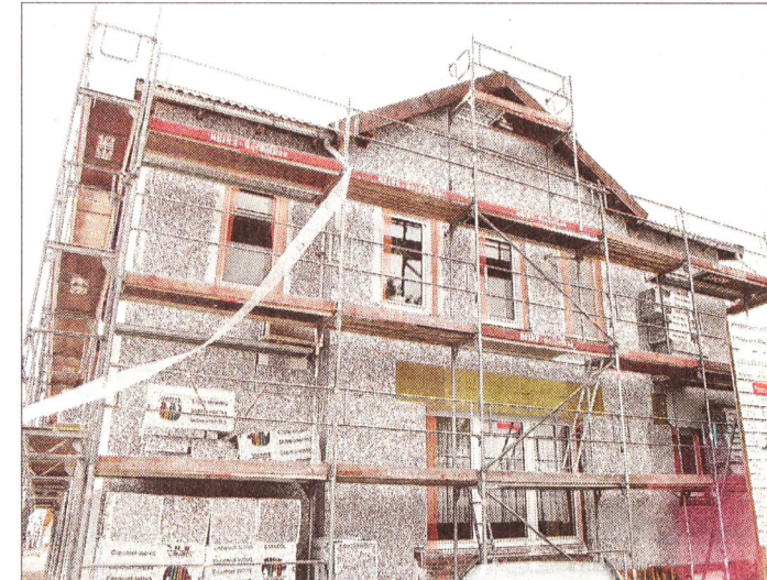
Der Altbau des Alten- und Pflegeheims wird saniert.
